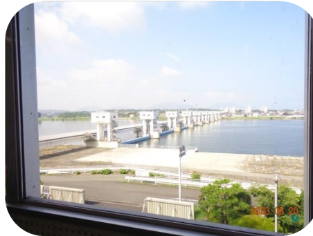
河川事務所から見た河口堰
